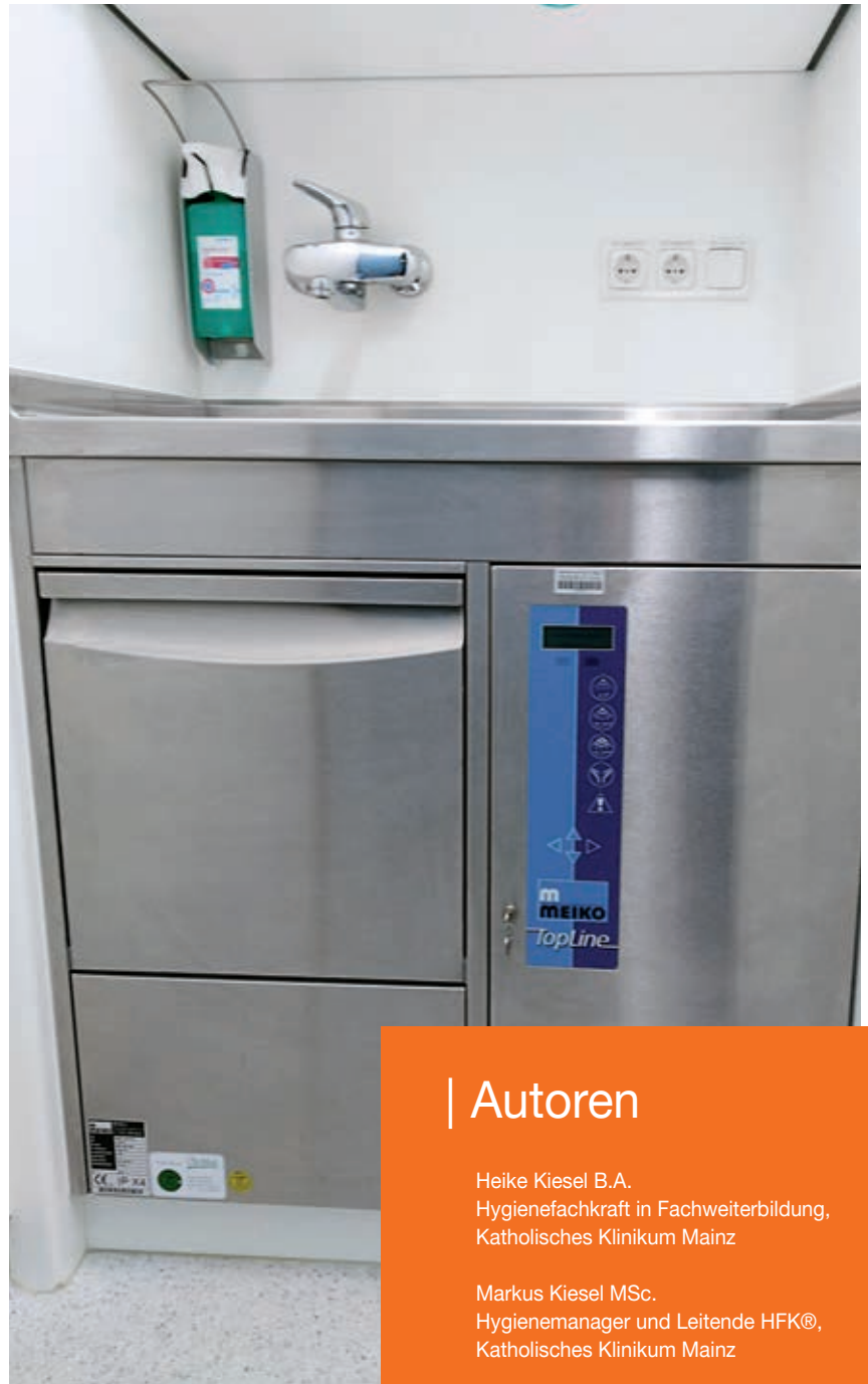
Abb. 1: Steckbeckenspüle im kkm (Quelle: Heike Kiesel B.A., kkm)
